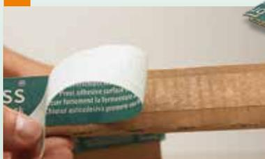
Silikonband vom Selbstklebeverschluss lösen
